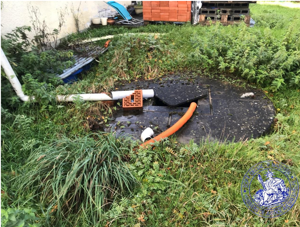
20. branchement effectué sur le puit
