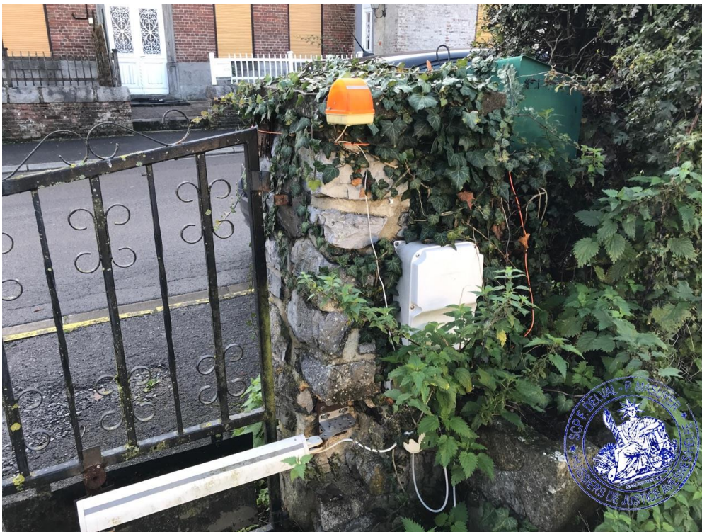
9. système de motorisation en mauvais état
