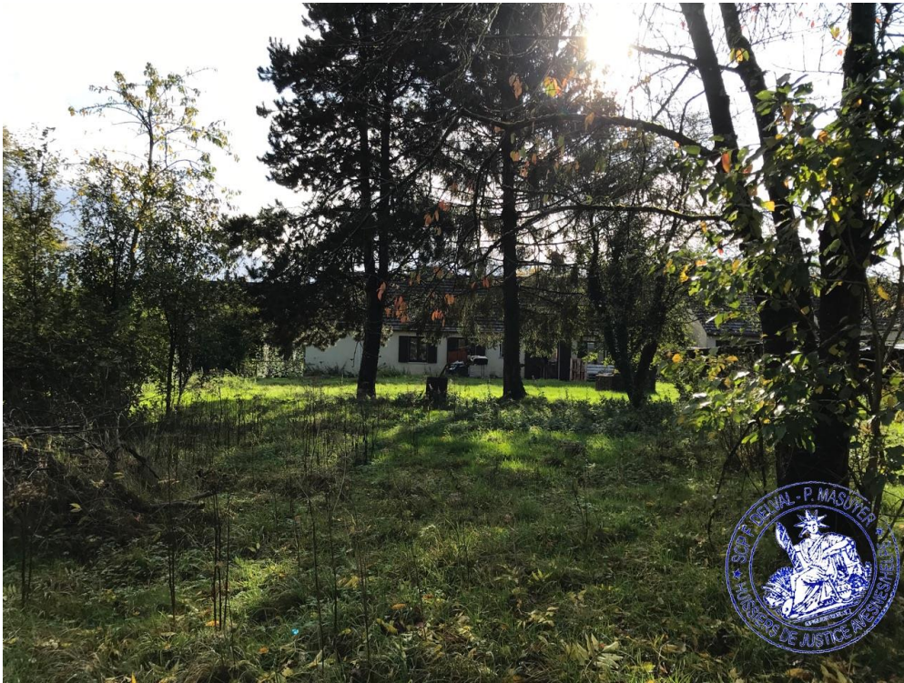
14. vue façade arrière
