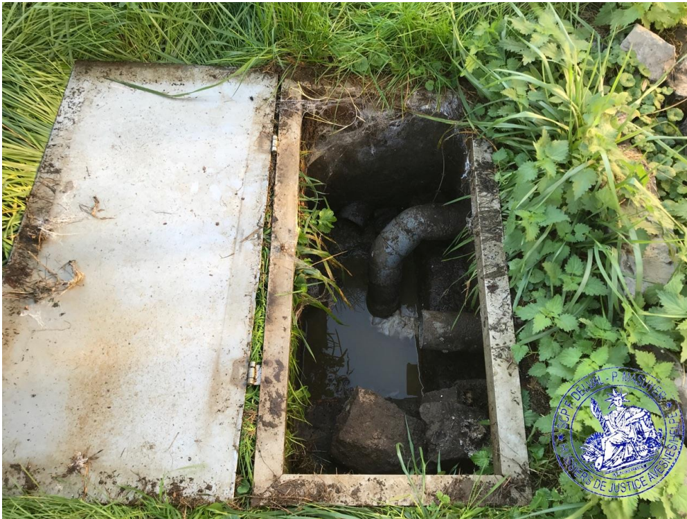
34. regard situé sur le terrain avant à côté porte d'entrée
