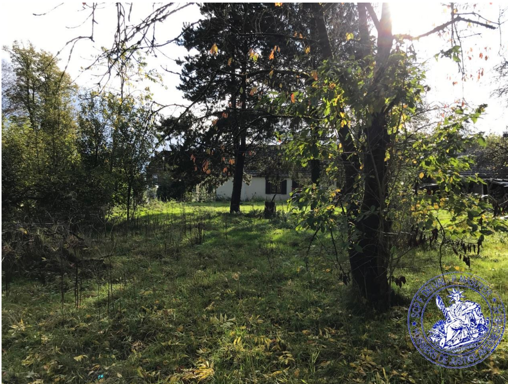
13. vue façade arrière
