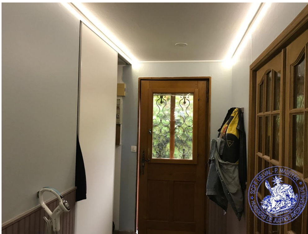
1. porte d'entrée présence d'un placard en état
