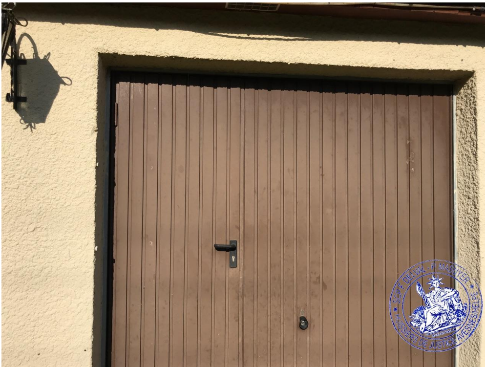
33. Garage façade avant
