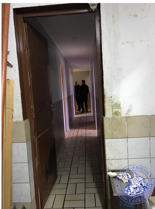
1. porte d'accès entre l'habitation principale
