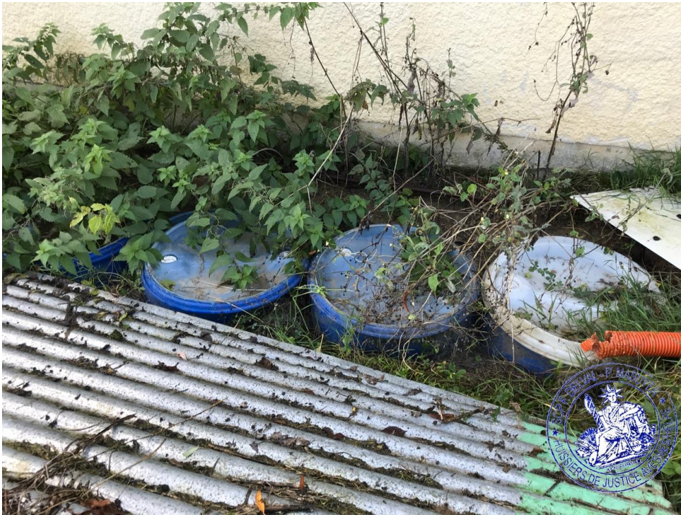
26. barils pour récupérer le trop plein des eaux pluviales
