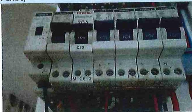
*Description :* Le courant assigné (calibre) de la protection contre les surcharges et courts-circuits d'au moins un CIRCUIIT n'est pas adapté à la section des CONDUCTEURS correspondants.
