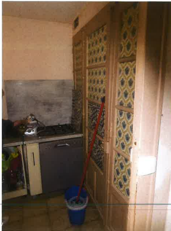
Au fond à droite, le nécessaire pour une machine à laver, surmonté d'une crédence. L'ensemble est en cours de rénovation.
