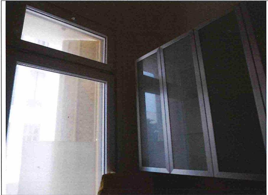
Il s'agit d'une pièce rectangulaire aérée et éclairée à l'Est par deux fenêtres, menuiseries en PVC, l'une à deux battants, l'autre à un battant, un carreau de vitre double vitrage par battant. L'obscurité est assurée par des volets pliants en métal.
