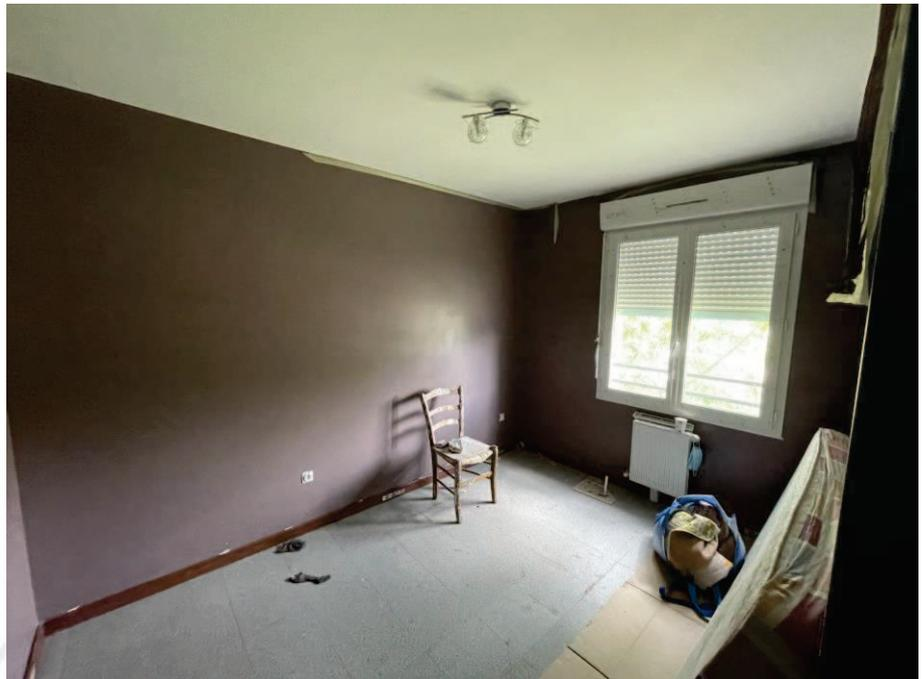
La pièce comporte une baie vitrée , deux pans ouvrants, châssis PVC double vitrage, la baie est sécurisée par un volet roulant mécanique, l'ensemble comporte encore les plastiques de protection.
