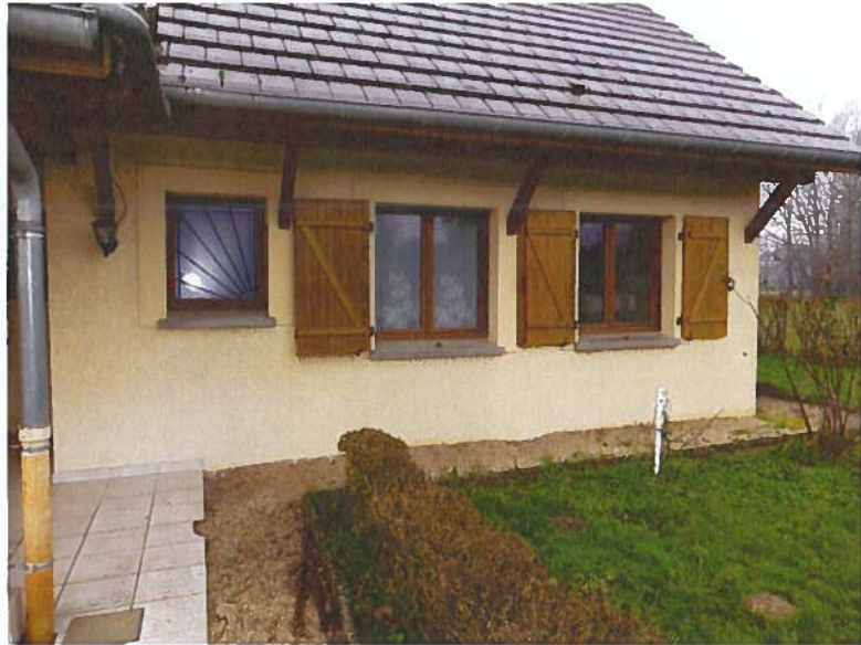
La façade Sud est recouverte d'enduit ton beige, en bon état. Il y a deux descentes de chéneau métalliques.
