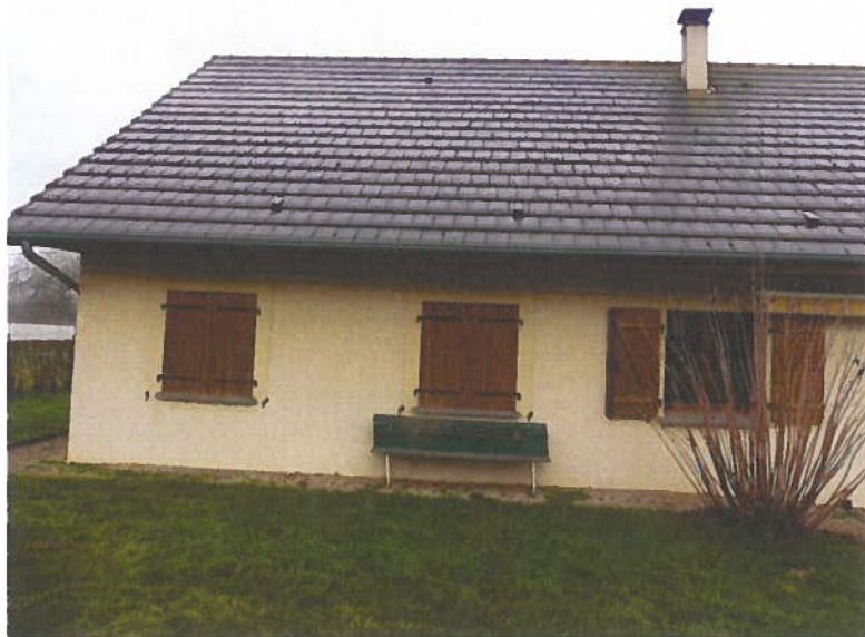
La façade Nord est recouverte d'enduit ton beige, en bon état. Il y a une descente métallique de chéneau.
