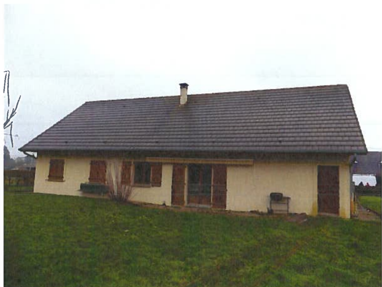
La façade Ouest est recouverte d'enduit ton beige, en bon état.
