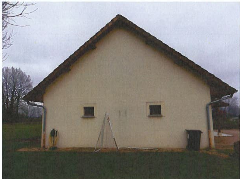
La façade Ouest est recouverte d'enduit ton beige, en bon état.
