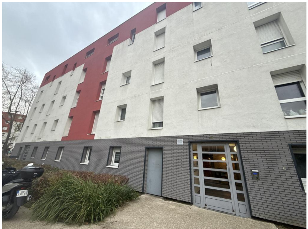
L'accès est sécurisé.
